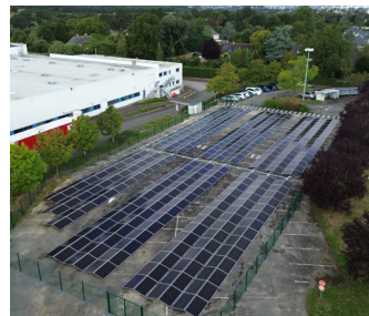
Vue aérienne de la centrale photovoltaïque au sol installée pour une capacité de 250 kWc.
